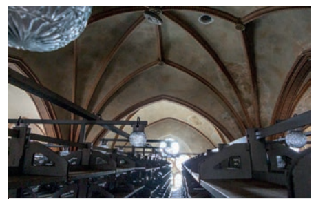
Regale und Gewölbedecke
