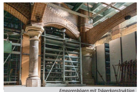
Emporenbögen mit Trägerkonstruktion
