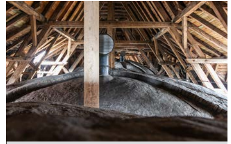
Dachkonstruktion über Gewölbedecke
