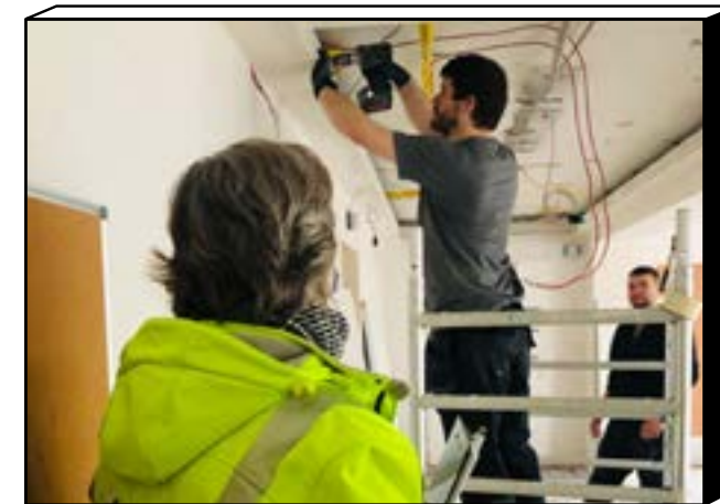
Baustelle Landesbildungszentrum Tangerhütte
