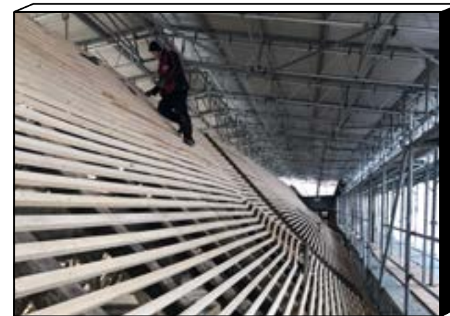
Baustelle Neue Residenz Halle (Saale)
