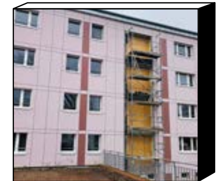
Baustelle Landesbildungszentrum Tangerhütte
