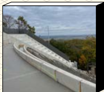
Zuwendungsbau, Hexentanzplatz Thale
