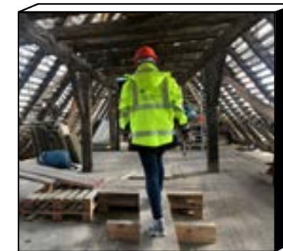
Baustelle Neue Residenz Halle (Saale)
