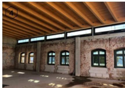
**Haus 4:** Das denkmalgeschützte Gebäude als größte Sanierungsmaßnahme auf dem Gelände, befindet sich derzeit im Rohbau. Ein neuer Dachstuhl entsteht.
