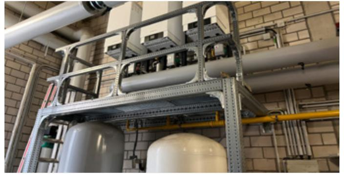
redundante Wärmeversorgung: Gas-Brennwertthermen
