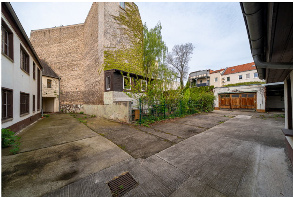
Abbildung 25 Blick über den Hof
