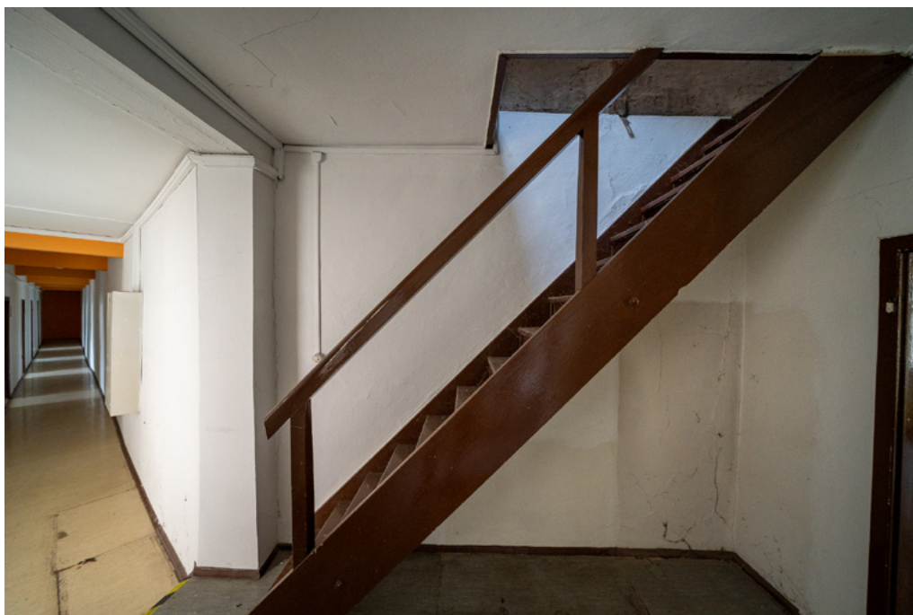
Abbildung 11 Zugang Dachgeschoss Vorderhaus
