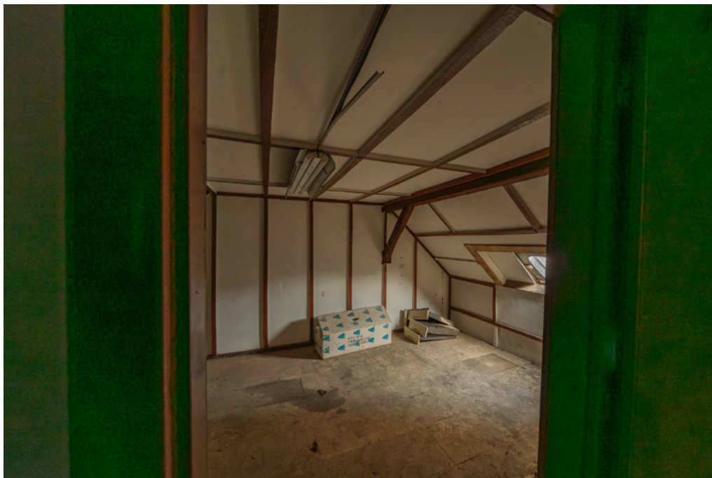
Abbildung 12 Lagerraum Dachgeschoss Vorderhaus
