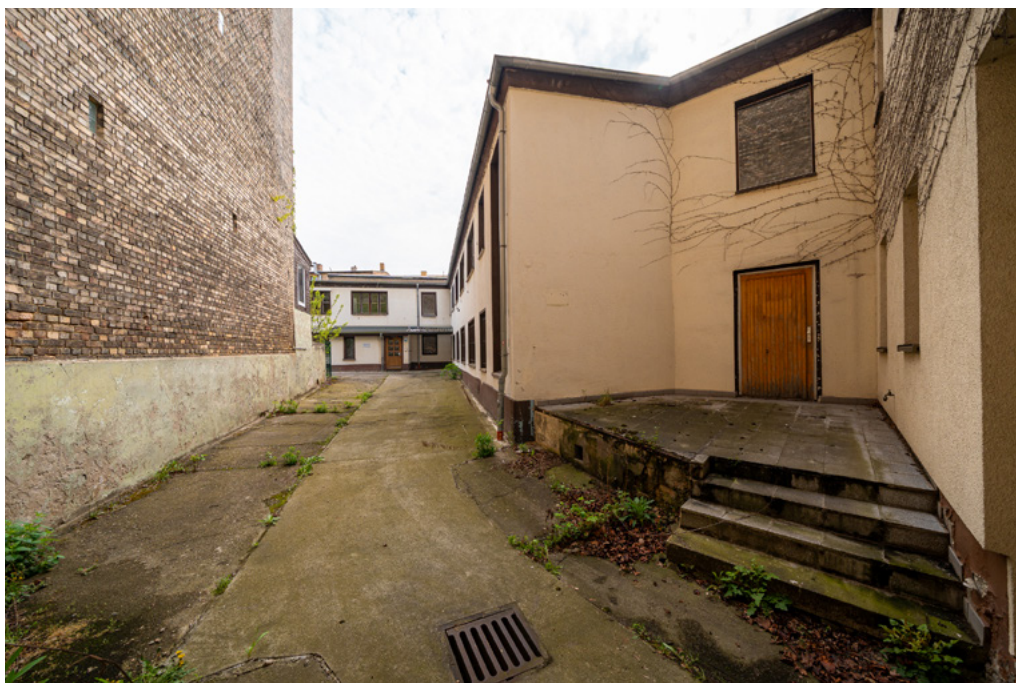
Abbildung 7 Eingangsbereich Vorderhaus & Seitenflügel mit Blick zum zweiten Eingang Seitenflügel
