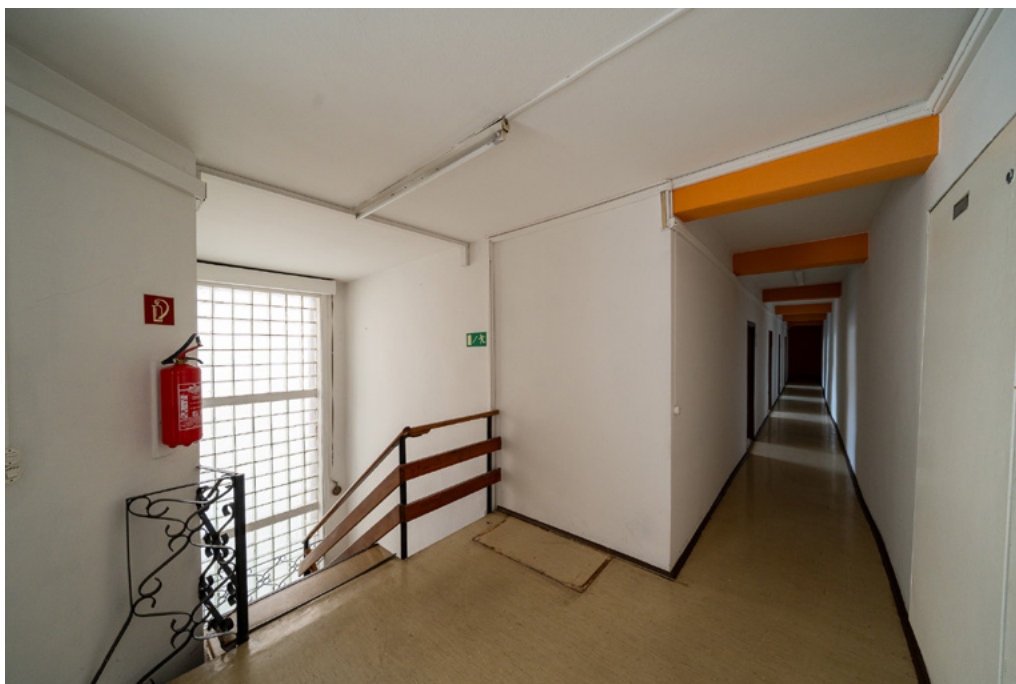
Abbildung 14 Gemeinsames Treppenhaus mit Blick in den Flur Seitenflügel
